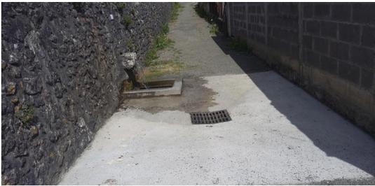
L'entreprise RONGERE a également reconfiguré l'écoulement de l'eau qui vient du château, modifié le diamètre de tuyau et recréé une dalle de propreté pour éviter également que l'eau ruisselle dans le chemin du Pissot au niveau de la fontaine. Coût : 2 950 euros.
